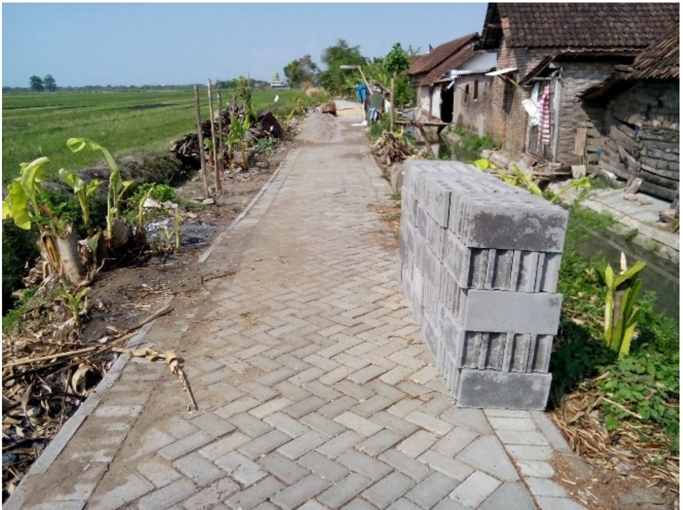
Figure 3. Dokumentasi Jalan Desa yang Telah Diperbaiki
